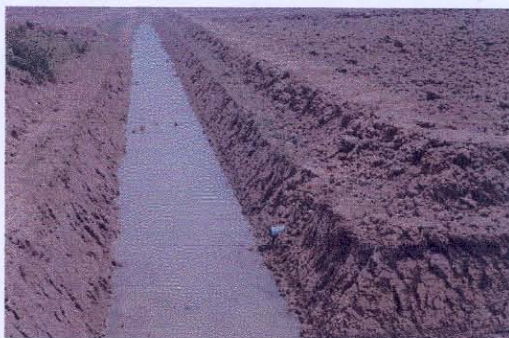
ภาพที่ 34 การขุดคูระบายน้ำทิ้งในแปลงนาที่ฟื้นฟู ดินที่เคยเป็นบ่อกุ้งร้าง
