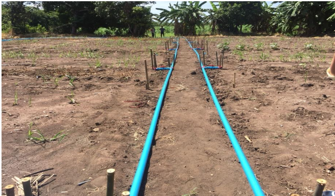
ภาพผนวกที่ 2 การติดตั้งระบบน้ำหยด
