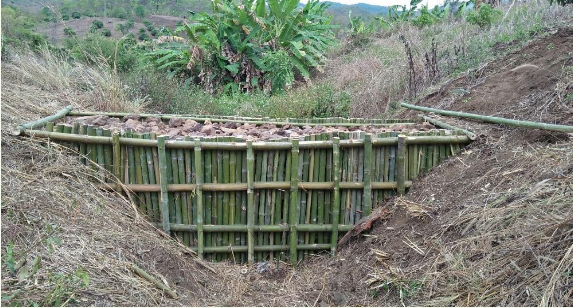
ภาพที่ 4.2 บ่อดักตะกอนและฝายแบบไม้ไผ่ จังหวัดเชียงใหม่
