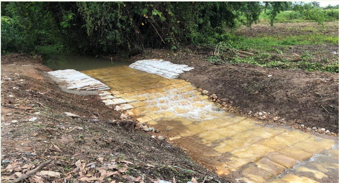
ภาพที่ 4.3 บ่อดักตะกอนและฝายแบบกระสอบ จังหวัดเชียงใหม่
