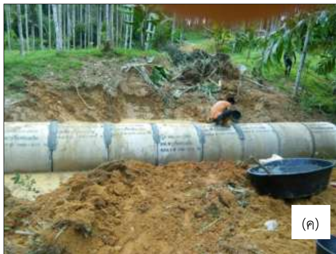
ภาพผนวกที่ 1 กิจกรรมฟื้นฟูป้องกันการชะล้างพังทลายดินได้แก่ คันดินแบบที่ 5 (ก), ทางลำเลียงในไร่นา (ข), ท่อระบายน้ำ (ค)
