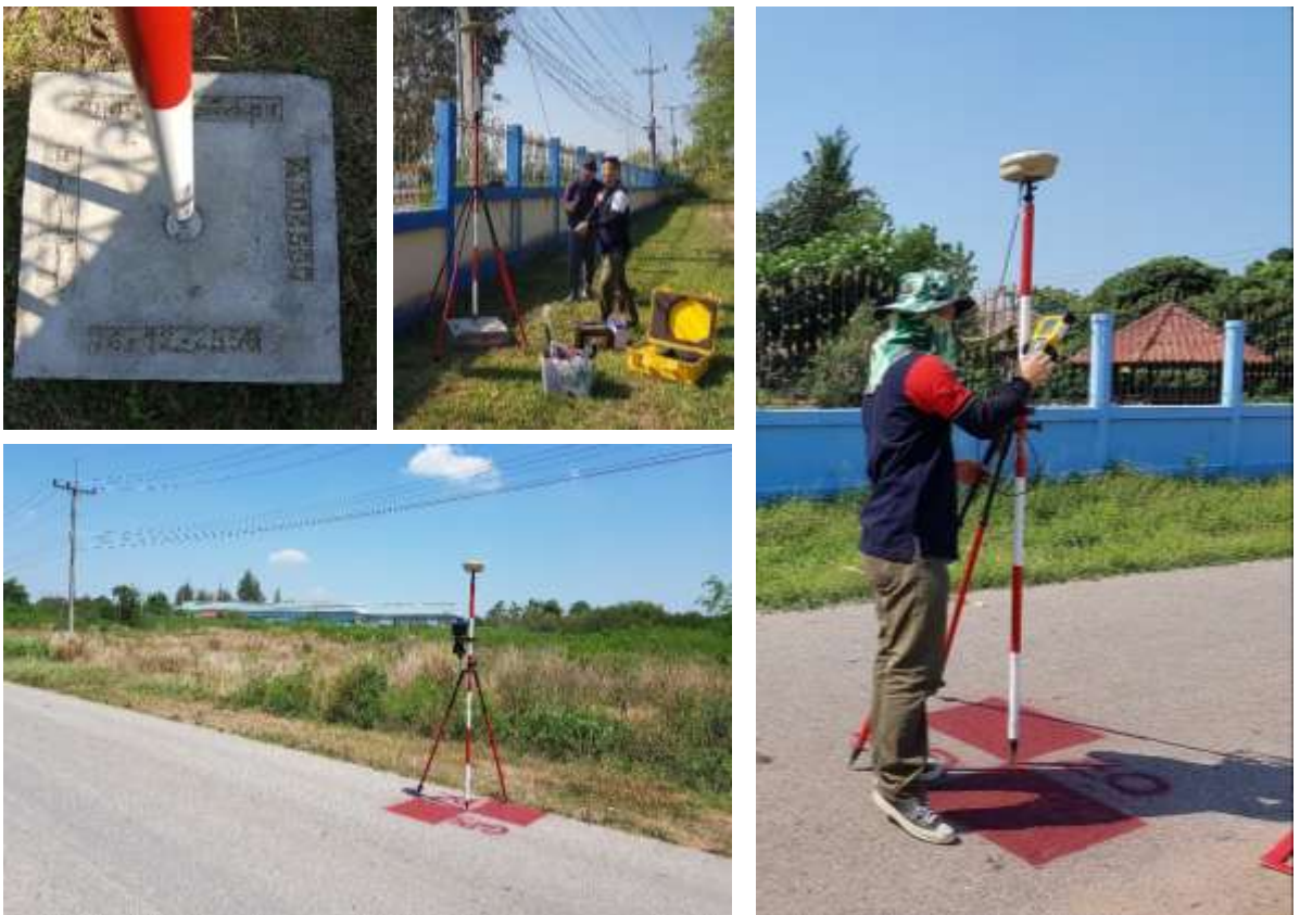
รูปที่ ๓๔ แสดงการรังวัดหมุดควบคุมภาคพื้นดิน ด้วยเครื่องรับสัญญาณดาวเทียม GPS วิธีการรังวัดแบบจลน์ได้ค่าพิกัดทันที ณ เวลาทำการรังวัด (Real Time Kinematics: RTK)
