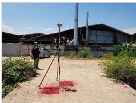
รูปที่ ๕๒ แสดงการรังวัดหมุดควบคุมภาพถ่ายและจุดตรวจสอบ
