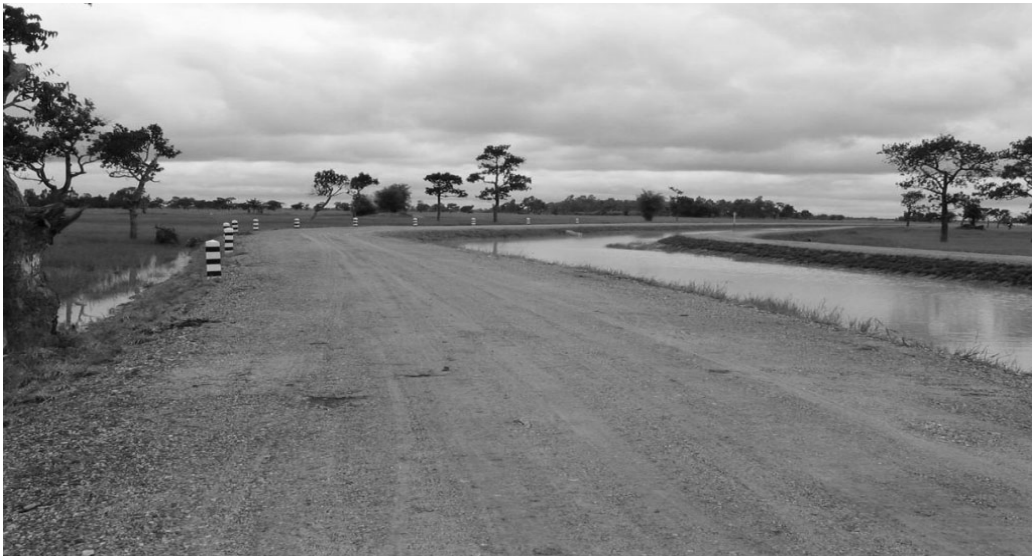
คลองระบายน้ำแบบที่ ๑ ที่ก่อสร้างแล้วเสร็จ
