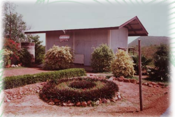
ภาพที่ ๒๔ อาคารสำนักงานเดิม
