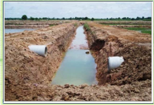
ภาพที่ ๕ การสร้างท่อลอดระบายเกลือ (Open drain)
