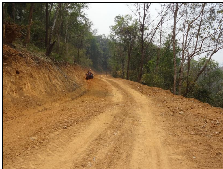
ภาพที่ 4.6 ทางลำเลียงที่ก่อสร้างเสร็จแล้ว
