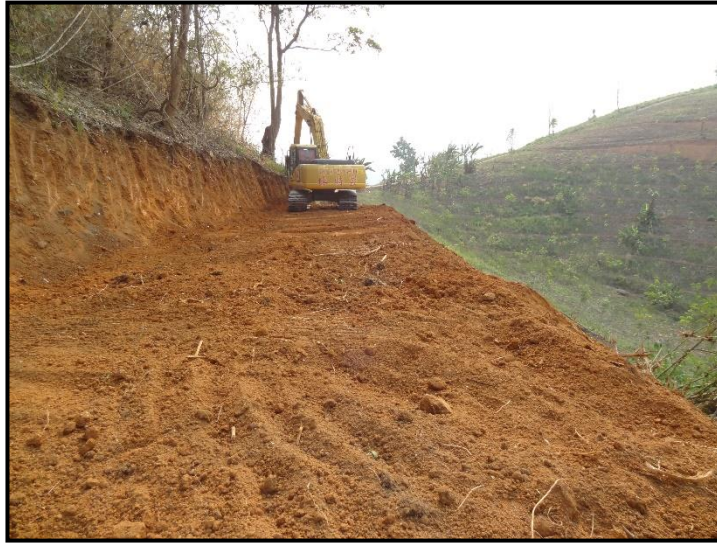
ภาพที่ 4.5 การก่อสร้างทางลำเลียง
