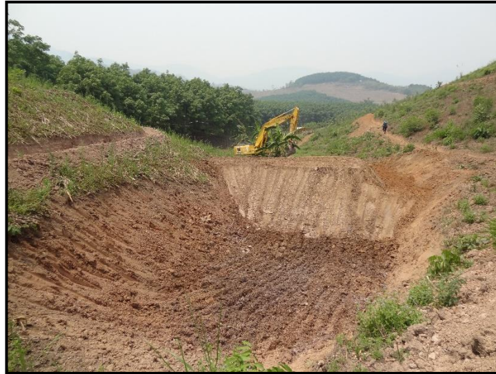
ภาพที่ 4.3 การก่อสร้างบ่อดักตะกอนดิน
