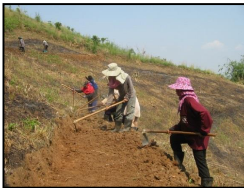
ภาพที่ 4.2 การก่อสร้างคันคูรับน้ำรอบเขาแบบที่ 6
