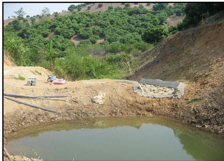
ภาพที่ 4.4 บ่อดักตะกอนดิน ที่ก่อสร้างเสร็จแล้ว
