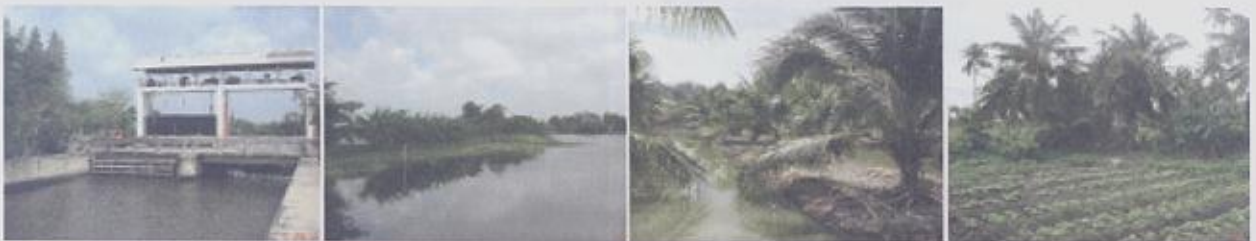
การสร้างประตูกันน้ำทะเลและระบายน้ำ
