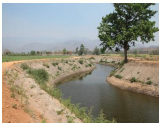
ภาพผนวกที่ 4-7 ทางระบายน้ำ (waterways)
