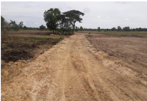
ภาพที่ 13 ทางลำเลียงในไร่นาที่ก่อสร้างในพื้นที่ดินเค็ม
