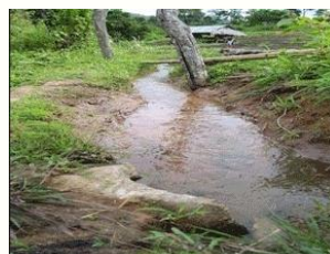
ทางระบายน้ำ
