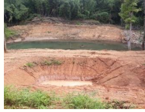
บ่อดักตะกอนดิน
