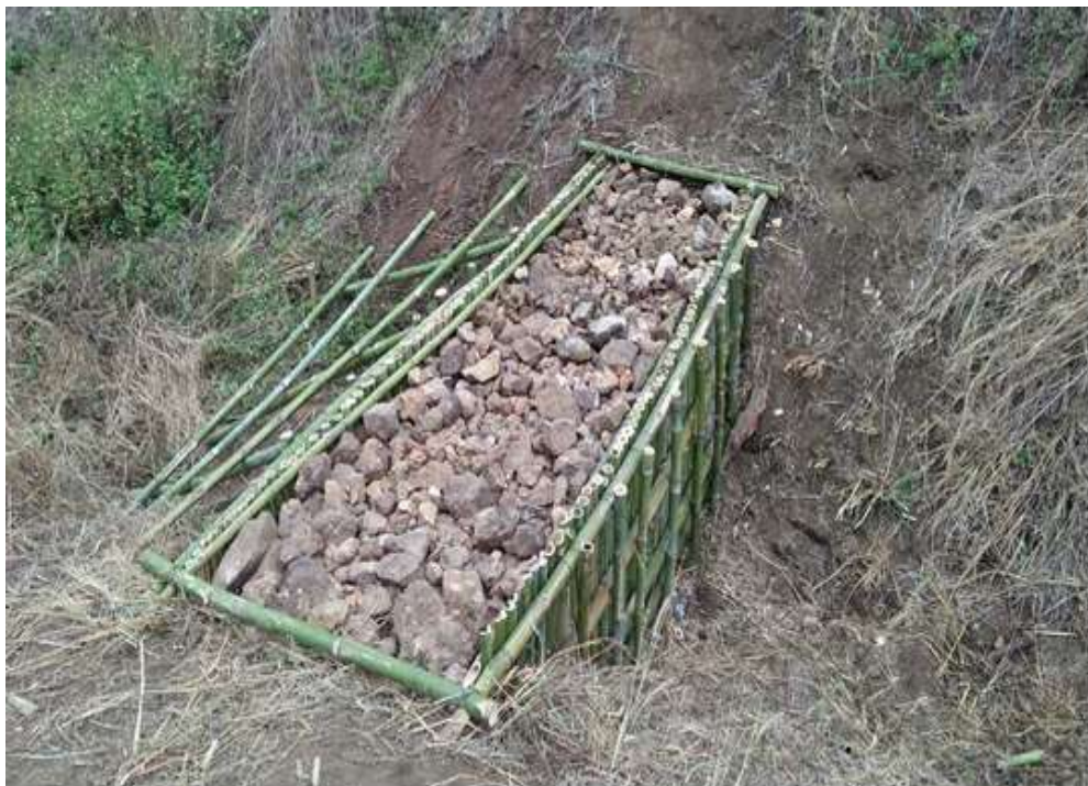
ภาพที่ 37 บ่อตักตะกอนดิน 70 บ่อตัก ถวายพ่อหลวง
