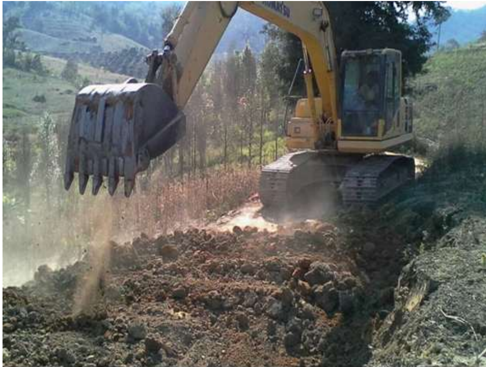
ภาพที่ 28 กิจกรรมการก่อสร้างทางลำเลียงในไร่ชา งานดินชุด
