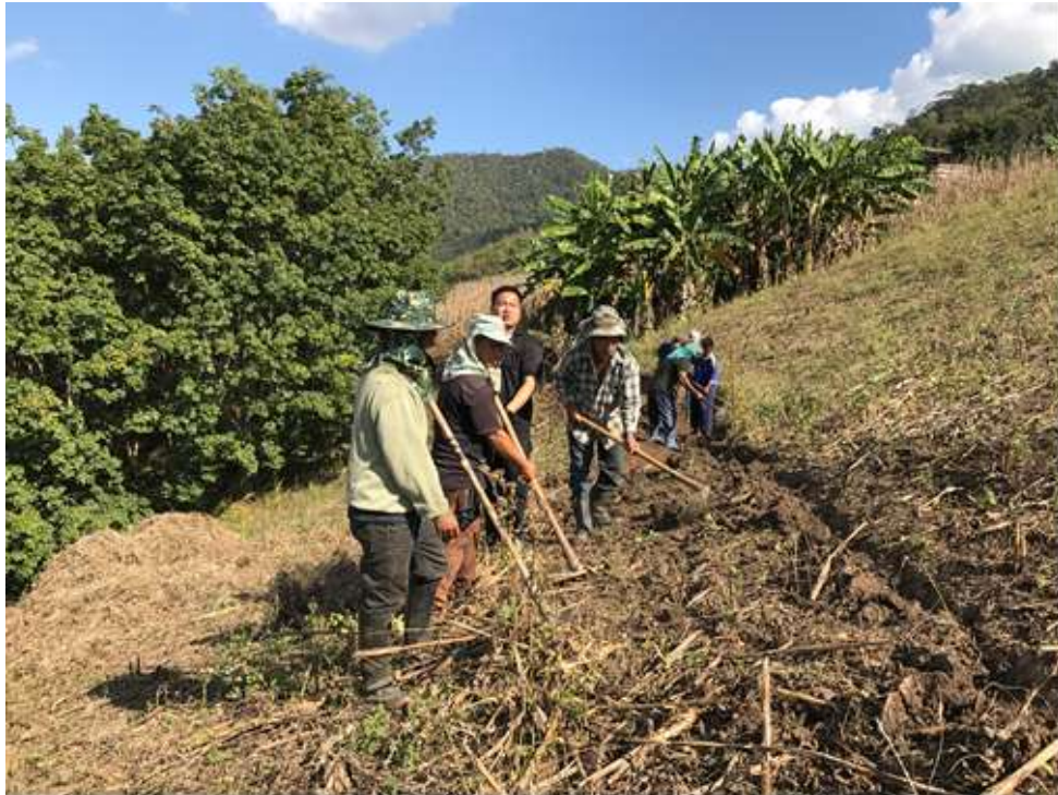
ภาพที่ 25 ดำเนินการก่อสร้างคันดินเบนน้ำ
