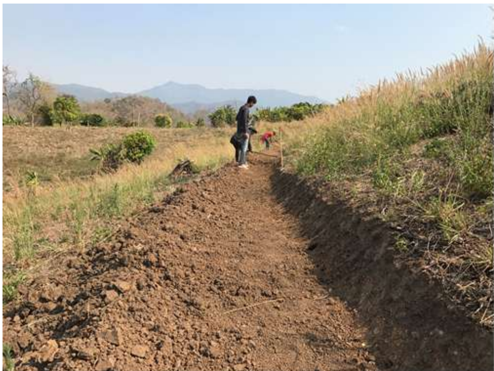
ภาพที่ 21 การดำเนินการก่อสร้างคันคูรับน้ำขอบเขา (คันดินแบบที่ 5)
