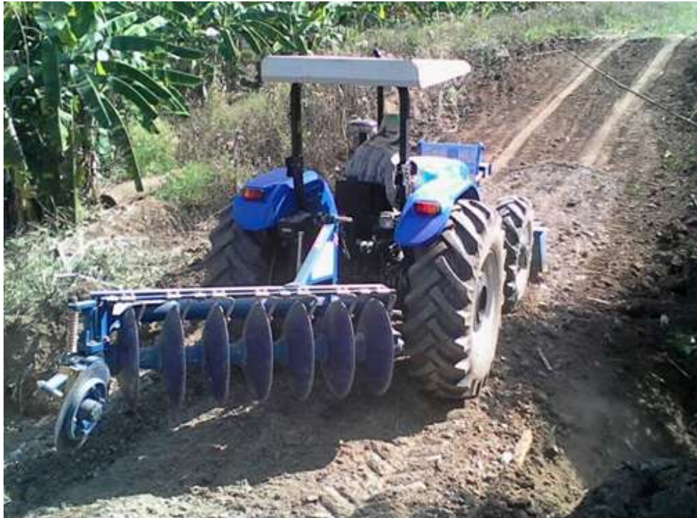
ภาพที่ 30 กิจกรรมการก่อสร้างทางลำเลียงในไร่นา ปรับผิวทางลำเลียง
