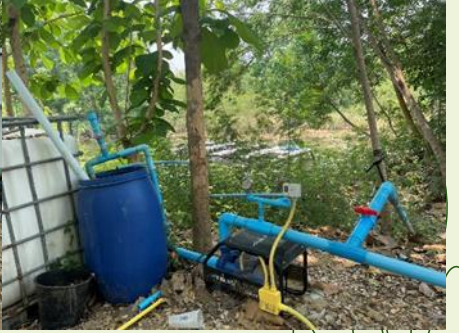
การนำเทคโนโลยี IoT (ระบบสูบน้ำพลังงานแสงอาทิตย์ แบบฟูลทูลออยน้ำ ในพื้นที่การเกษตร) ที่สามารถสั่งการทำงาน และแสดงผลการทำงานผ่านโทรศัพท์มือถือแบบสมาร์ตโฟน
