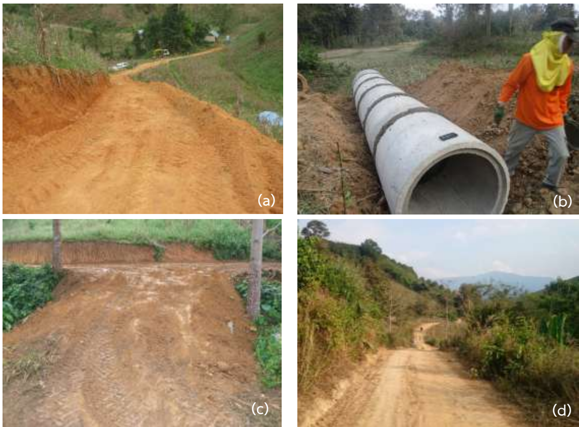
ภาพที่ 28 (a,d) การก่อสร้างทางลำเลียงในไร่นา (b) วางท่อคอนกรีตเสริมเหล็ก พร้อมยาแนวประสานท่อ และ (c) การย้ายดินถมท่อคอนกรีตเสริมเหล็ก
