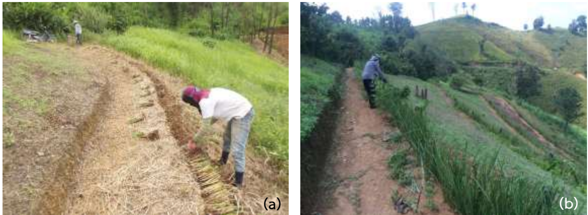
ภาพที่ 29 การปลูกหญ้าแฝกแบบรากเปลือย (a) เริ่มปลูกในต้นฤดูฝนบนขอบคูรับน้ำขอบเขา และ (b) ตัดใบเมื่ออายุครบ 3 เดือน คลุมโคนไม้ยืนต้น
