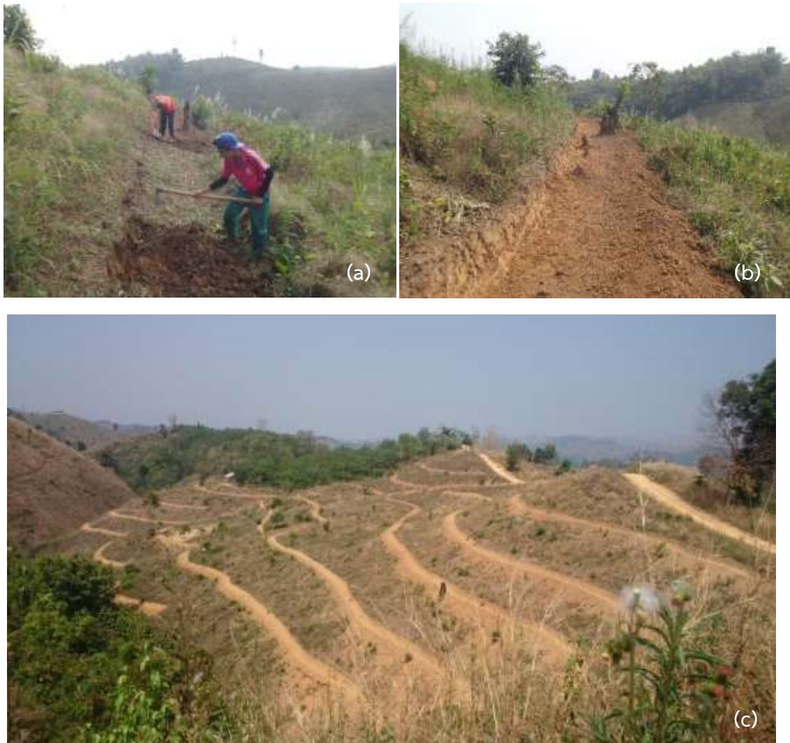
ภาพที่ 27 การก่อสร้างคูรับน้ำขอบเขา (คันดินแบบที่ 6) (a) ใช้แรงงานคนในการขุด และ (b-c) ลักษณะการตัดหน้าดินเมื่อขุดเสร็จแล้ว และระยะห่างของแต่ละคัน
