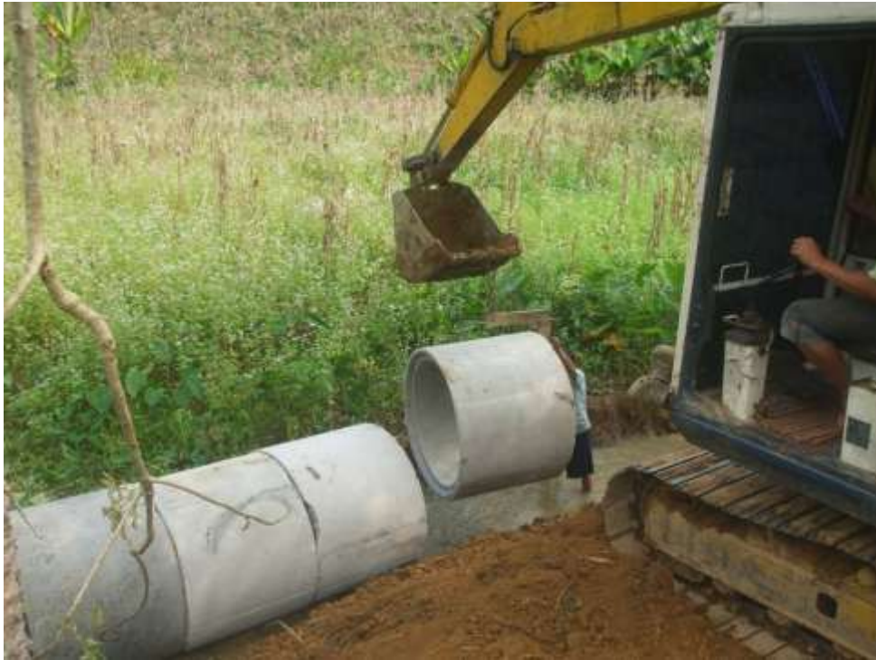
ภาพภาคผนวกที่ 6 การวางท่อคอนกรีตเสริมเหล็ก เพื่อระบายน้ำในพื้นที่
