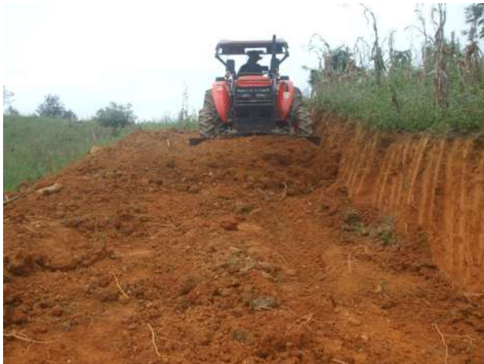
ภาพภาคผนวกที่ 7 การก่อสร้างทางลำเลียงในไร่นา รถไถตัดหน้าดินเดิมออก
