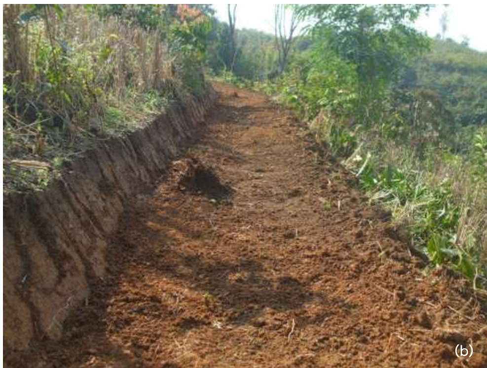
ภาพภาคผนวกที่ 5 (a) การก่อสร้างคูรับน้ำขอบเขา แบบที่ 6 โดยใช้แรงงานคนขุด (b) ลักษณะคูรับน้ำขอบเขา เมื่อก่อสร้างเสร็จแล้ว ความกว้าง 1.50 เมตร ความลึกของดินตัด 0.50 เมตร
