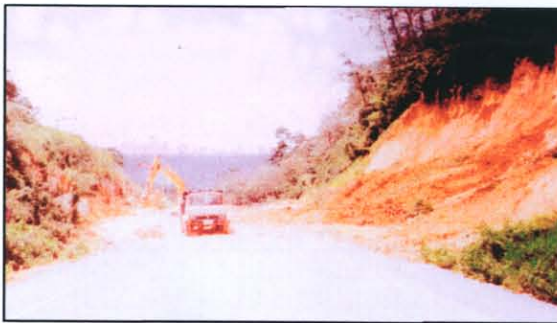
รูปที่ 2.5 ดินถล่มจากเขาลงมาตามไหล่ทาง ปิดขวางถนน ที่จังหวัดภูเก็ต
