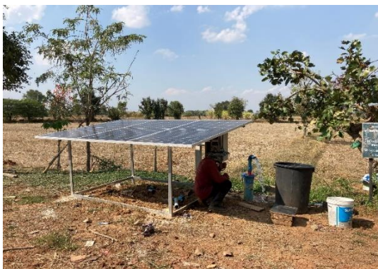
ภาพที่ 6 บ่อน้ำบาดาลสูบน้ำด้วยโซลาร์เซลล์ซึ่งเกษตรกรดำเนินการเอง
