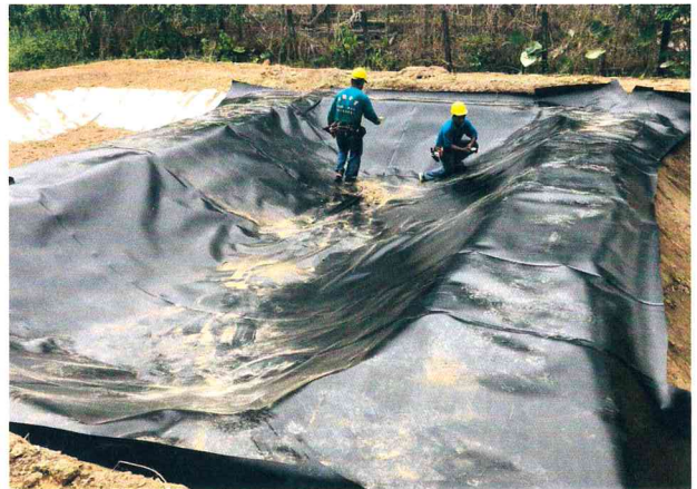
ภาพการปูผ้ากันน้ำกันสระ (พื้นที่สาธิตสาทล- 2019)
