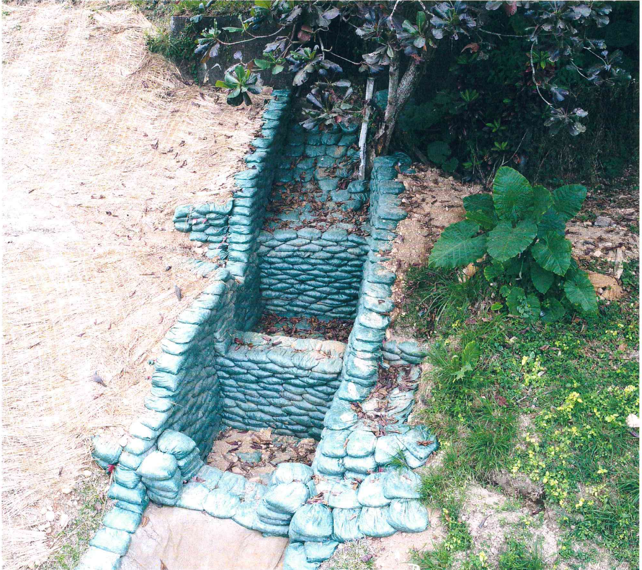
บ่อพักน้ำล้นกรวดหิน (พื้นที่สาริตสาทล 2018)
