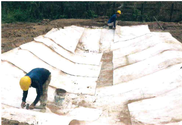
ภาพการปูผ้ากันน้ำกันสระ (พื้นที่สาธิตสาทล- 2019)
