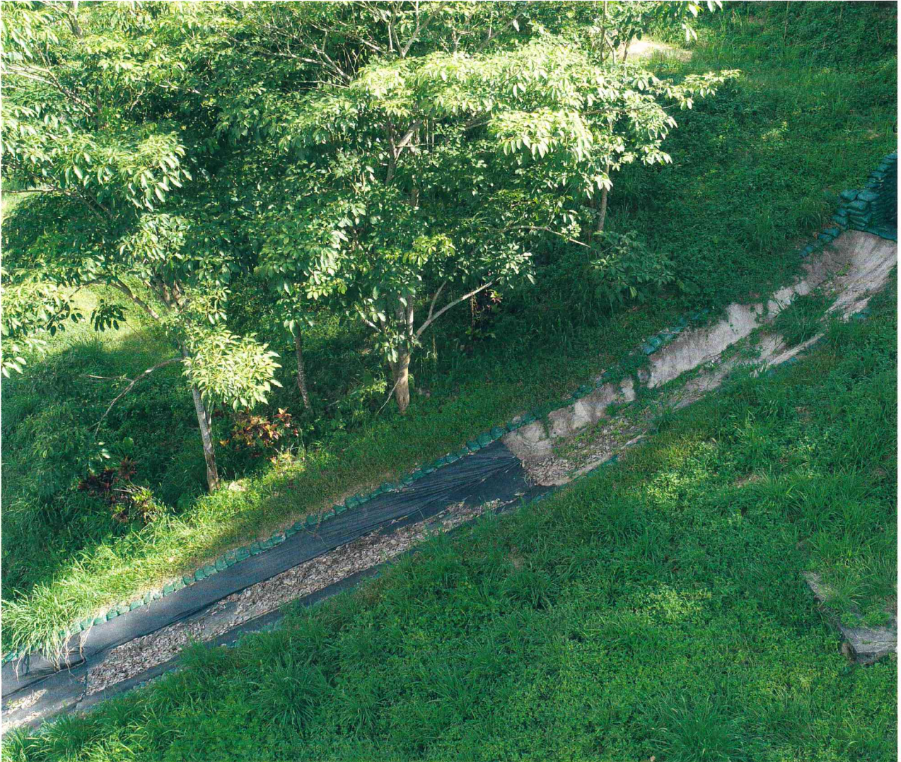
การปูพื้นฐานคูระบายน้ำด้วยวัสดุผสม(พื้นที่สาธิตสาทล 2018)
