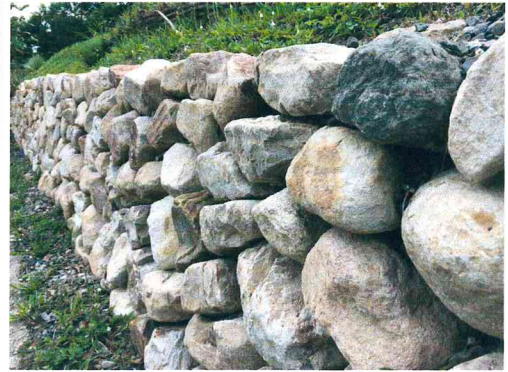
กำแพงหินปกป้องเนิน (พื้นที่สาริตสากล 2019)
