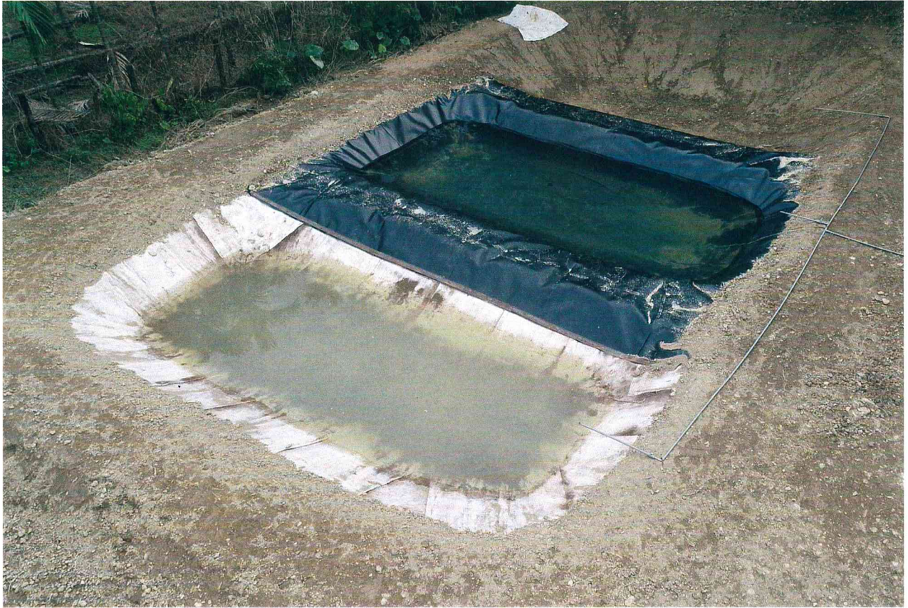
สระเก็บน้ำเพื่อการเกษตรแบบขุด เพิ่งทำเสร็จ (พื้นที่สาธิตสาทล- 2019)
