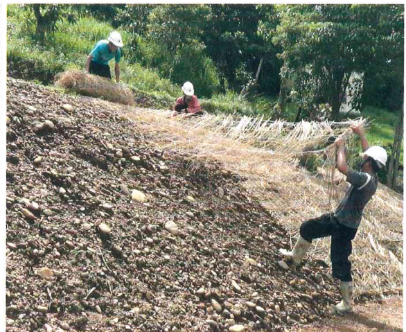
สภาพขณะทำการคลุมดินด้วยเสื่อฟาง (พื้นที่สาริตสากล 2018)
