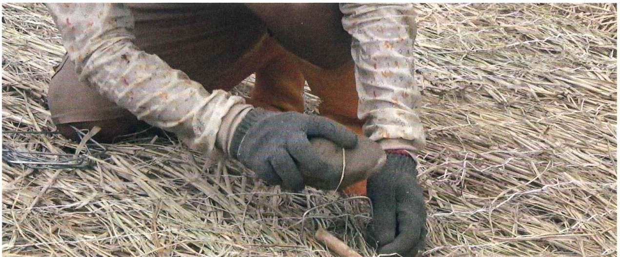
การปูเสื่อฟางคลุมดินและตอกตัวยึด (พื้นที่สาธิตสาทล 2018)
