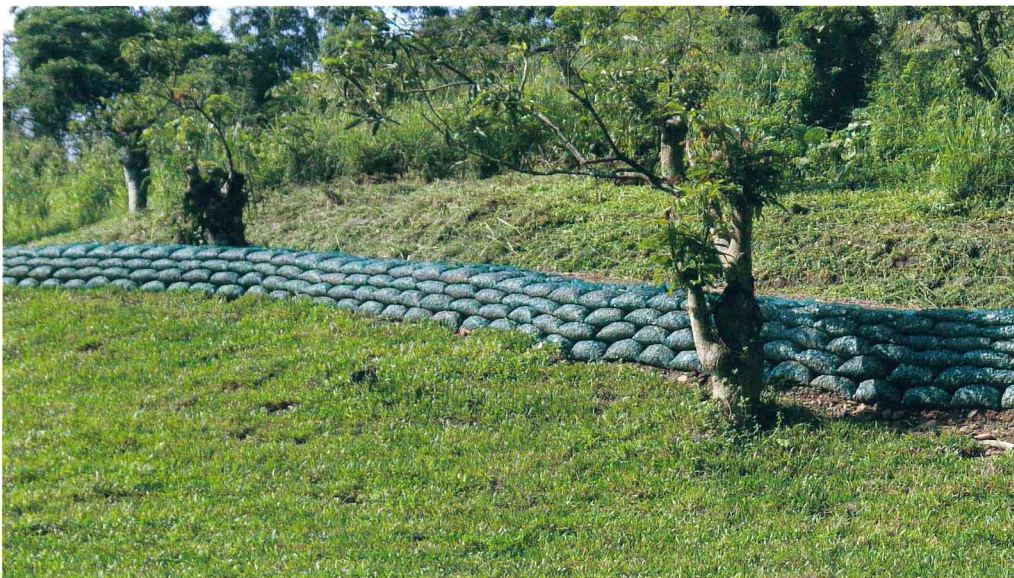
ปฏิบัติการปกป้องเนินด้วยกระสอบกรวดหิน (พื้นที่สาธิตสาทล 2018)
