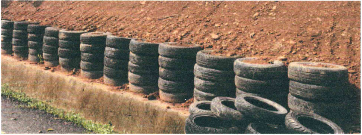
กำแพงล้อยางที่เพิ่งสร้างเสร็จ (พื้นที่สาธิตสาธิต 2018)
