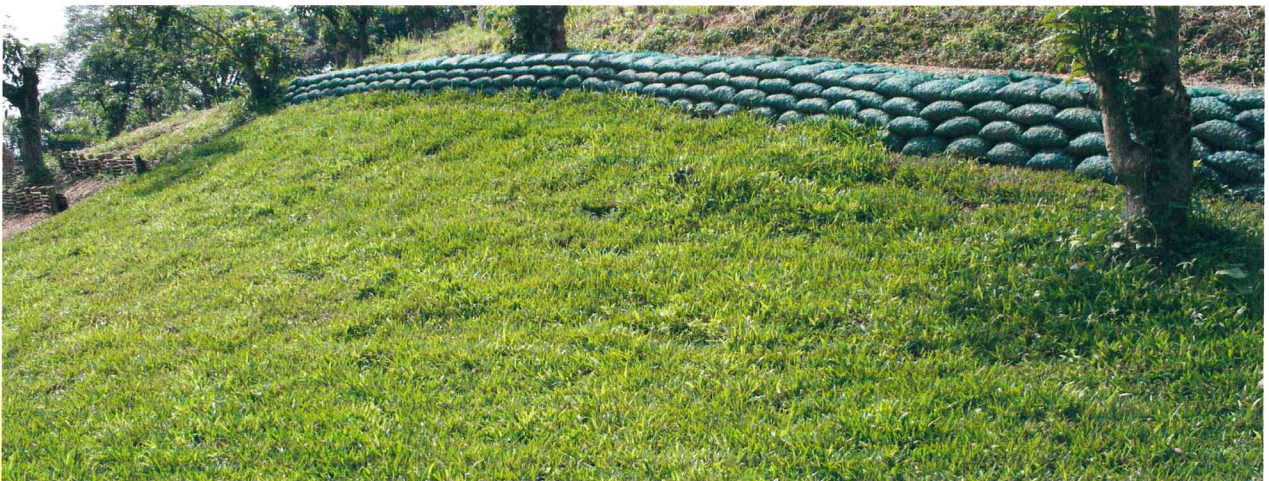
การปูหญ้าคลุมดิน (พื้นที่สาธิตสาทล 2018)
