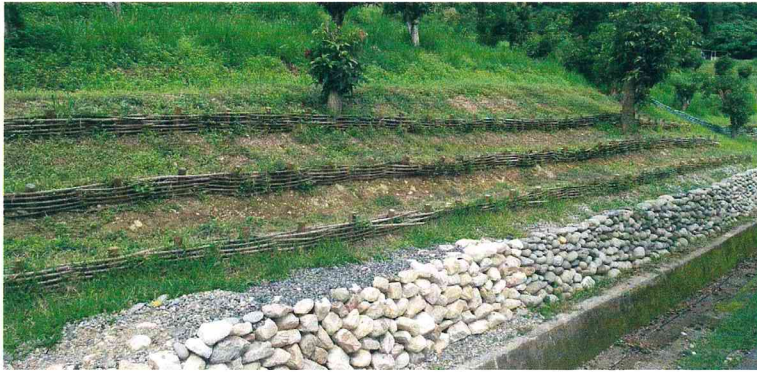
สภาพแวดล้อมเขตรฐานกำแพงหินปกป้องเนิน (พื้นที่สาริตสากล 2018)
