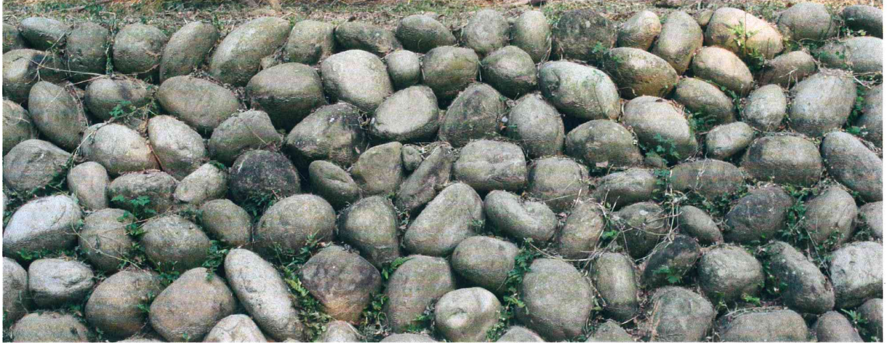
การจัดเรียงให้เริ่มจากชั้นล่าง (ห้องเรียนกลางแจ้ง การอนุรักษ์น้ำ เฟิงสุ่ยผิง - 2019)
