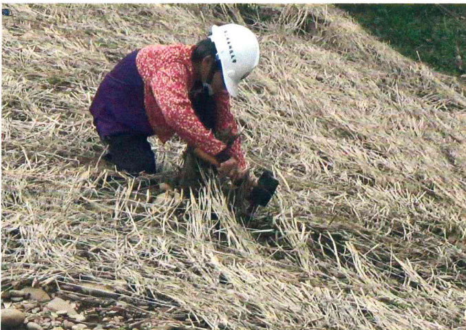
สภาพขณะทำการคลุมดินด้วยเสื่อฟาง (พื้นที่สาริตสากล 2018)
