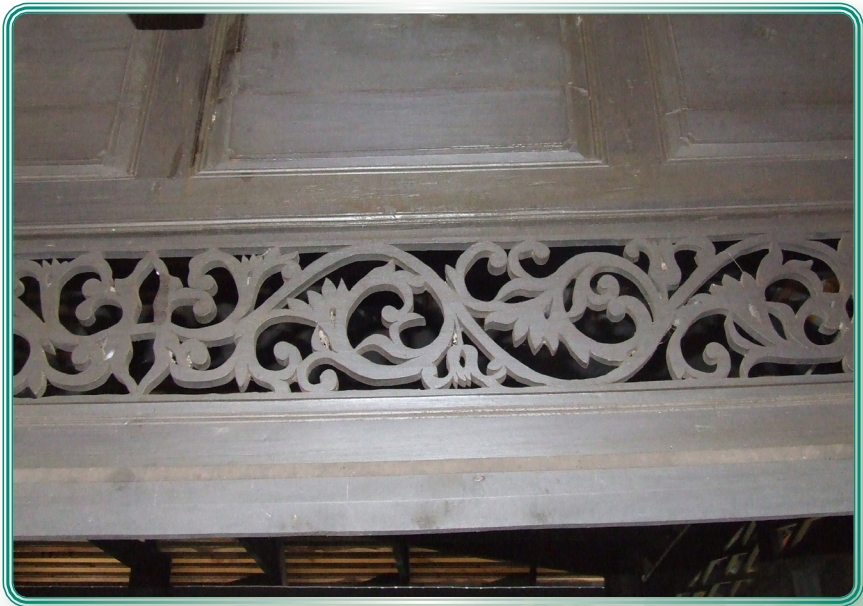
ภาพที่ 8 เจึงชาย และลายฉลุทำจากไม้ตานหก ในบ้านผู้ใหญ่วิบูลย์ เข็มเฉลิม จังหวัดฉะเชิงเทรา
