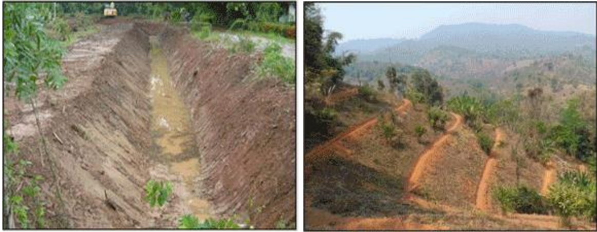
ภาพที่ 2 การอนุรักษ์ดินและน้ำโดยวิธีกล ด้วยการทำคันดิน และคูรับน้ำขอบเขา ที่มา: กรมพัฒนาที่ดิน (ม.ป.ป.)
