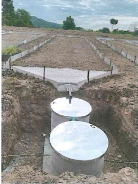
ภาพที่ 3.9 การติดตั้งบ่อซีเมนต์สำหรับดักน้ำและตะกอนในแปลงทดสอบในพื้นที่จังหวัดประจวบคีรีขันธ์
