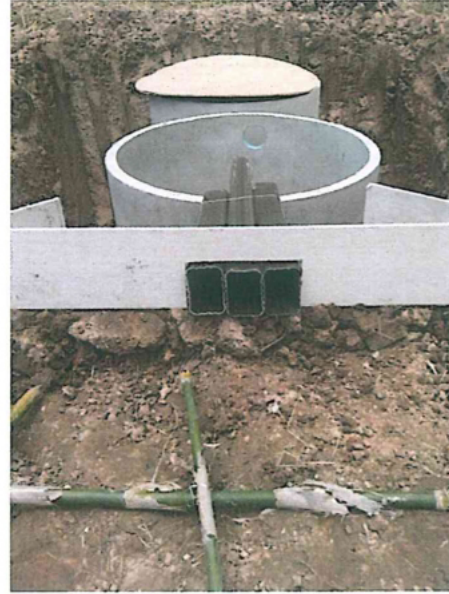
ภาพที่ 3.9 การติดตั้งบ่อซีเมนต์สำหรับดักน้ำและตะกอนในแปลงทดสอบในพื้นที่จังหวัดประจวบคีรีขันธ์
