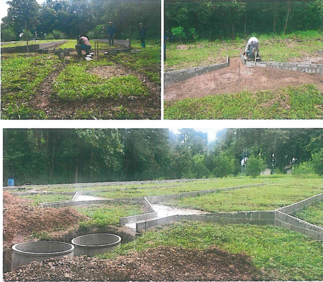
ภาพที่ 3.4 การก่อสร้างแปลงทดสอบการสูญเสียดินขนาดกว้าง 5 เมตร ยาว 20 เมตร ในพื้นที่จังหวัดเชียงใหม่
