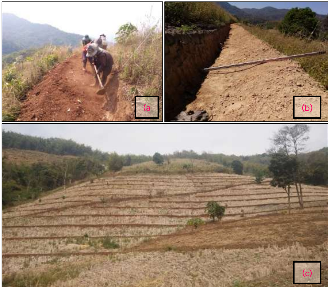
ภาพที่ 11 การก่อสร้างคูรับน้ำขอบเขา (คันดินแบบที่ 6) ใช้แรงงานคนในการขุด (a) และลักษณะการตัดหน้าดินเมื่อขุดเสร็จแล้ว และระยะห่างของแต่ละคัน (b-c)
