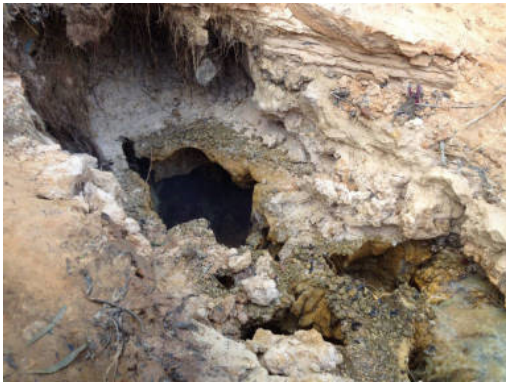
ภาพที่ 6 การวิบัติของดินที่ปรากฏโพรงท่อจากการกัดเซาะภายในโครงสร้างดิน
