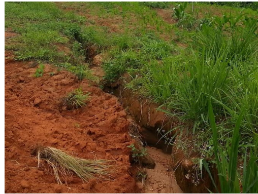
ภาพที่ 6 การวิบัติของดินที่ปรากฏโพรงท่อจากการกัดเซาะภายในโครงสร้างดิน
